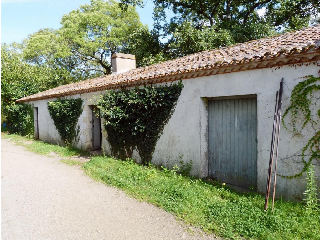
Figure 24 : Les locaux avant restauration...
