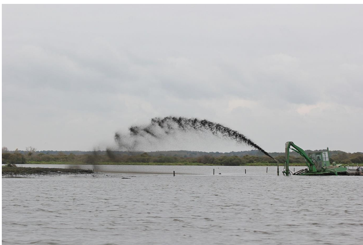
Figure 4 : Dévasage du débouché du canal Guerlain vers la zone centrale
