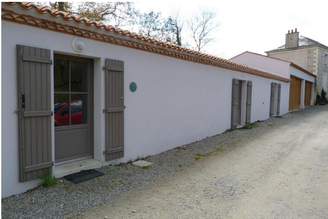
Figure 25 : Locaux de la Réserve après restauration
