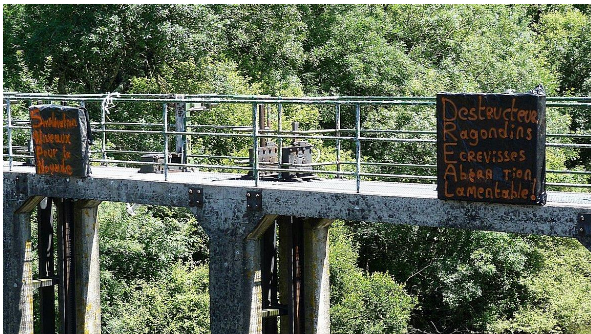
Figure 2 : Panneaux mettant en cause SNPN et DREAL sur le vannage de Bouaye, reste de la manifestation.
