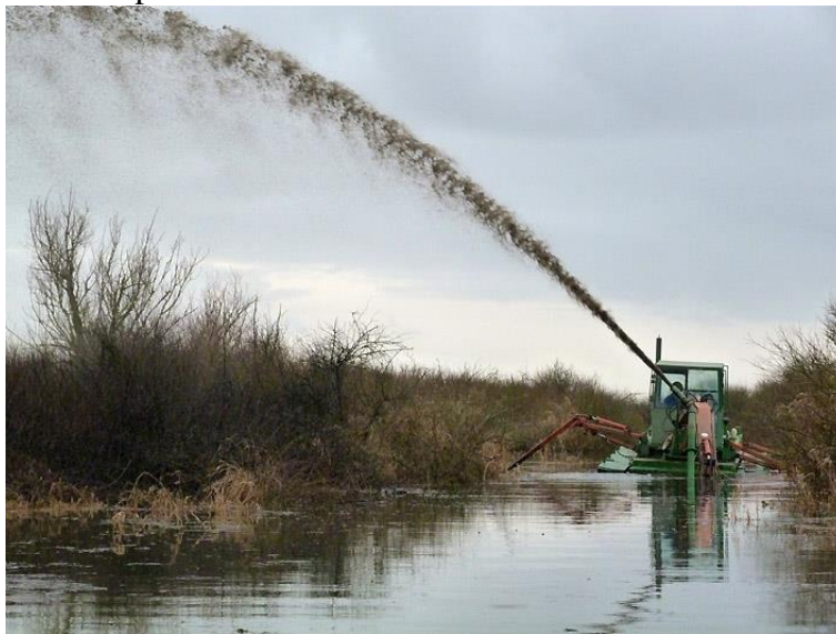
Figure 35 : Curage d'une douve à la drague et au canon à vase
