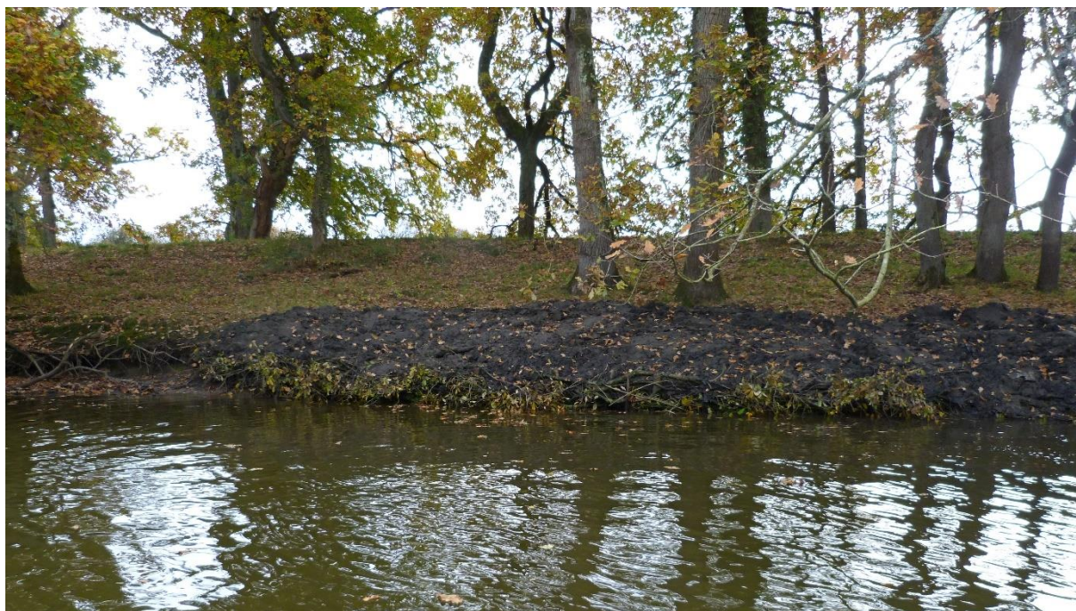
Figure 11 : Secteur test de confortement de berge avec des techniques végétales (pieux et fascines) et rechargement avec des sédiments fins extraits du canal de l'Etier
