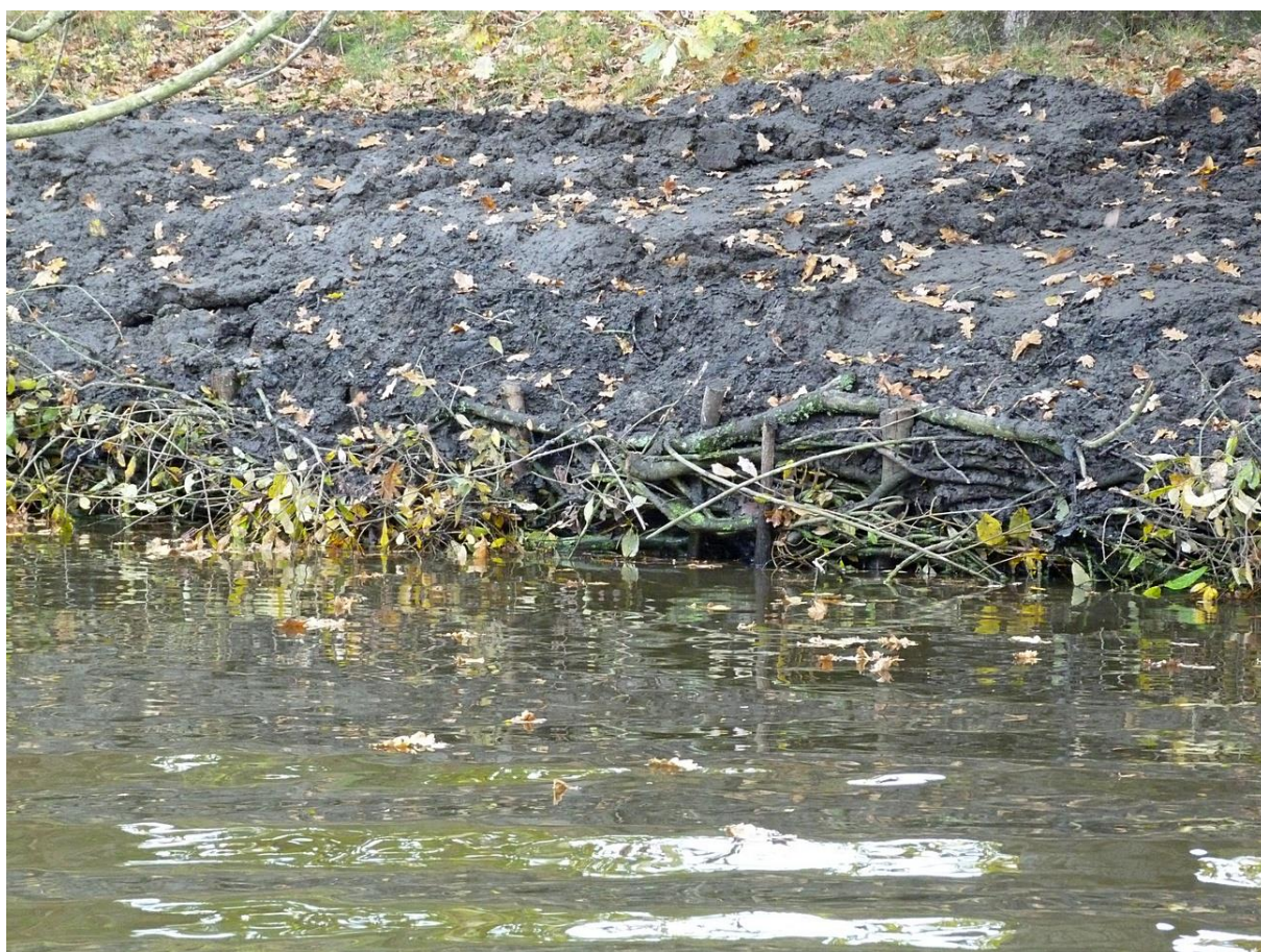
Figure 12 : Détail du confortement de berge
