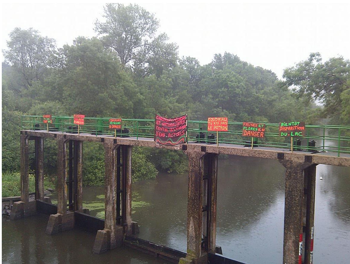
Figure 1 : Panneaux sur le vannage suite à la manifestation des chasseurs réclamant des niveaux d'eau plus hauts
