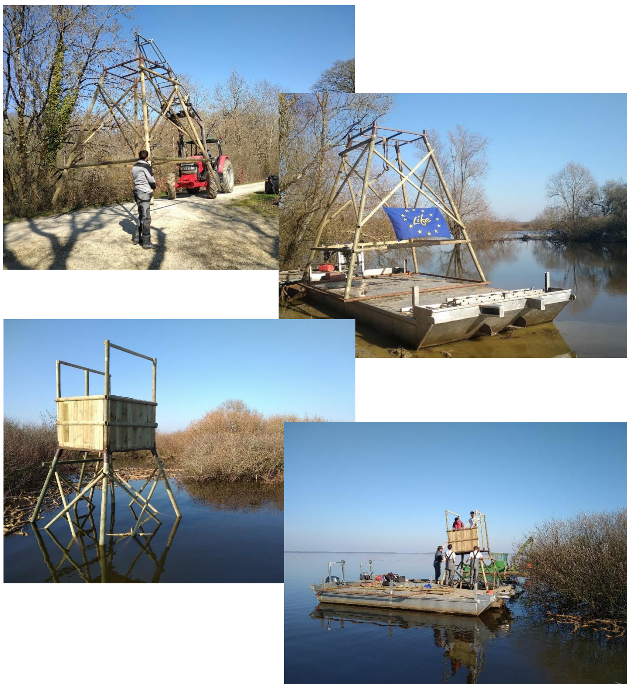
FIGURE 50 : PHOTOS DES DIFFERENTES PHASES DE CONSTRUCTION DES MIRADORS D'AFFUT ET DE LEUR MISE EN PLACE
