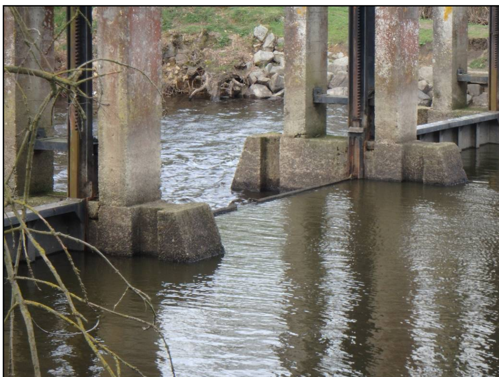
Figure 18 : Vanne centrale le 28 février 2017 (FISH-PASS)
