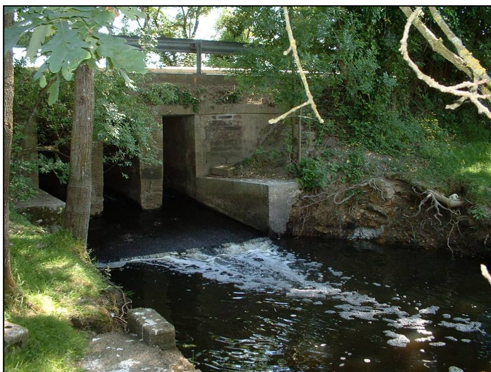
Figure 23 : Aval du seuil de Maison Blanche par surverse (FISH-PASS)
