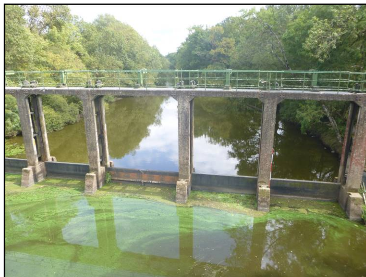
Figure 14 : Vue aval de l'ouvrage de Bouaye (FISH PASS)
