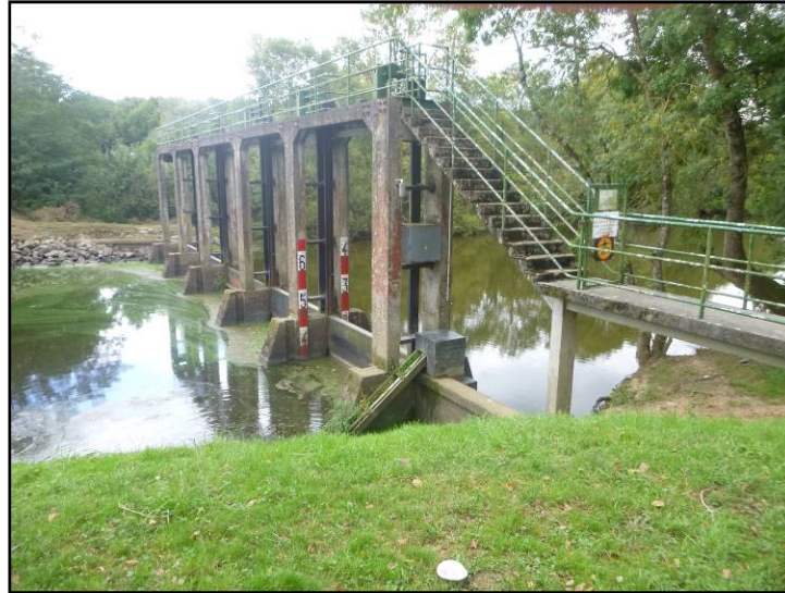
Figure 13 : Vue de côté de l'ouvrage de Bouaye (FISH PASS)
