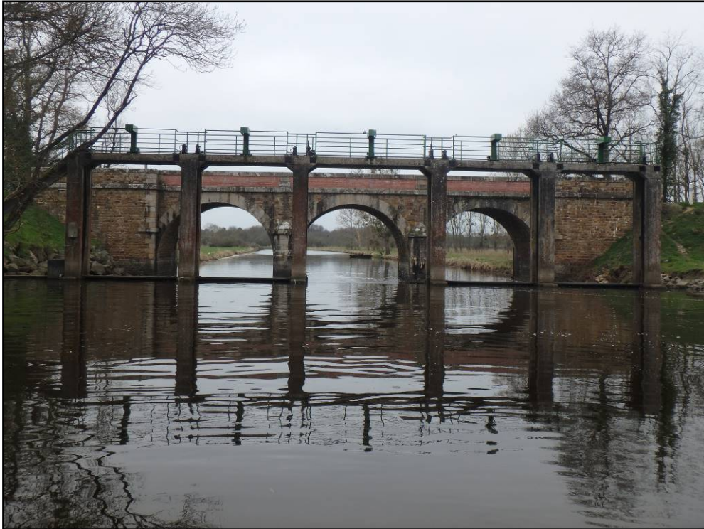
Figure 19 : Surverse par la vanne centrale le 15 mars 2017 (FISH-PASS)
