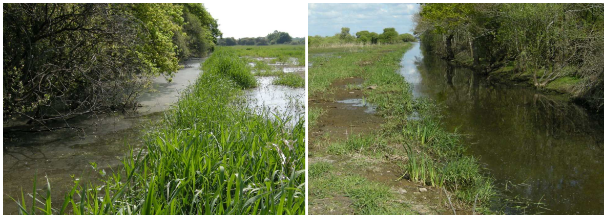
Figures 34 et 35 : Ruisseau en bordure des prairies des Bonhommes au printemps 2011, avant travaux (à gauche), et au printemps 2012, après travaux (à droite).
