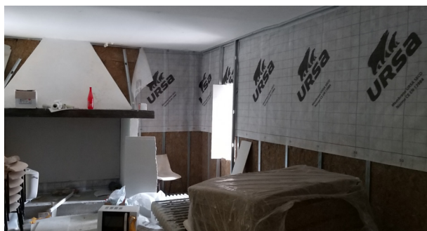
> Travaux d'isolation dans Phare de la Gachole
