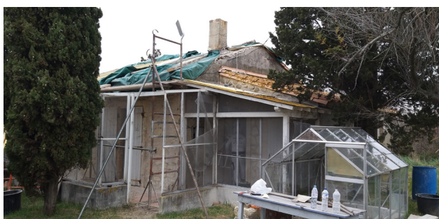
> Travaux de la Cantonnière en mars 2022
