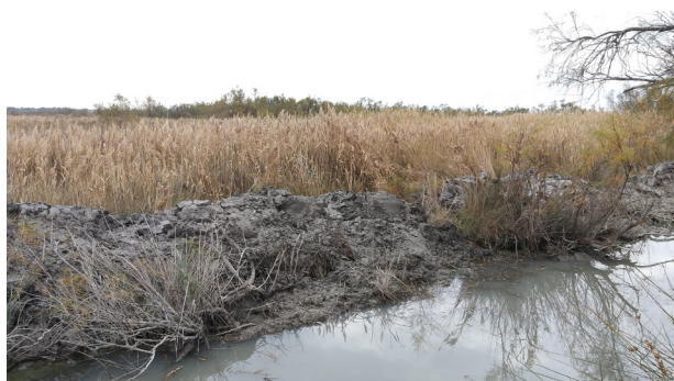
> Travaux de curage sur le canal en novembre 2022
