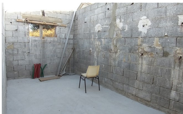
> Reprise de la maçonnerie du cabanon
